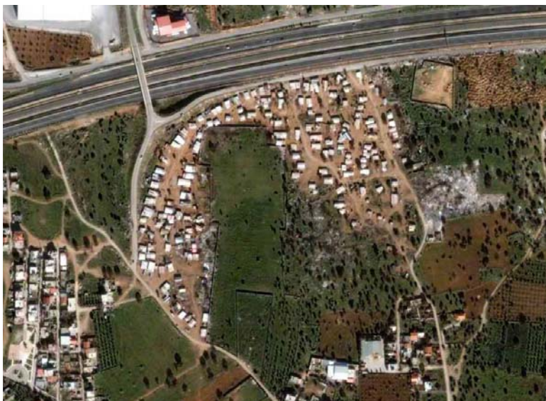
καταυλισμός στην περιοχή Ψάρι Δήμου Ασπροπύργου
